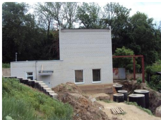
Здание КНС по ул. Гастелло
