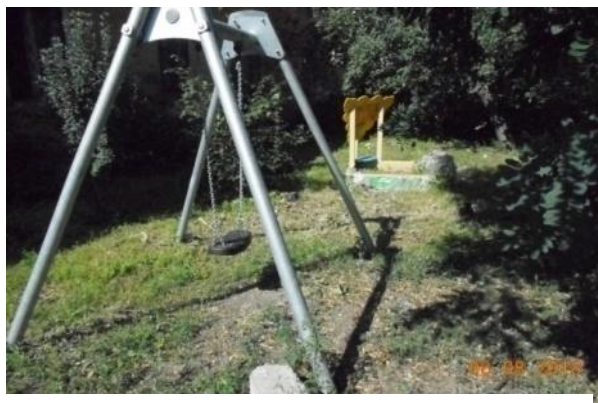
Отсутствие ударопоглощающего покрытия на ул. Батуриная, 29
