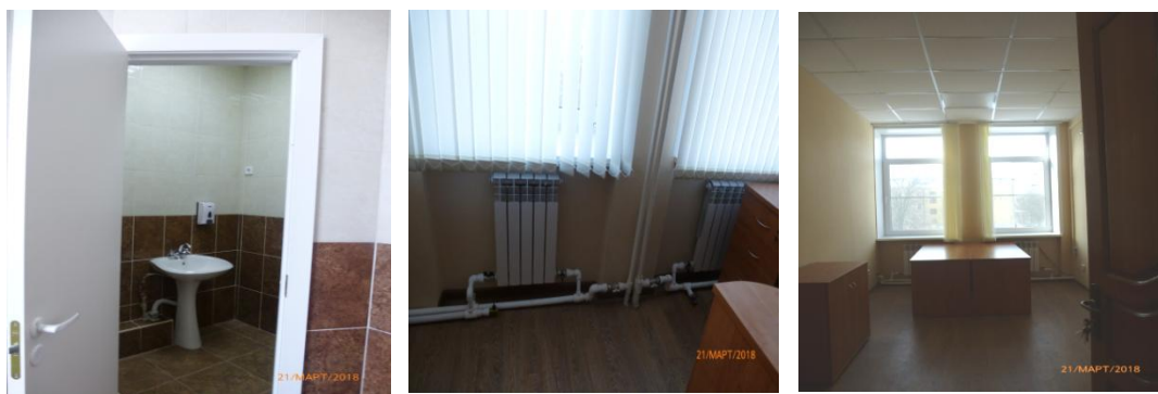
Помещения управы Центрального района (ул. Никитинская, 8) после ремонта
